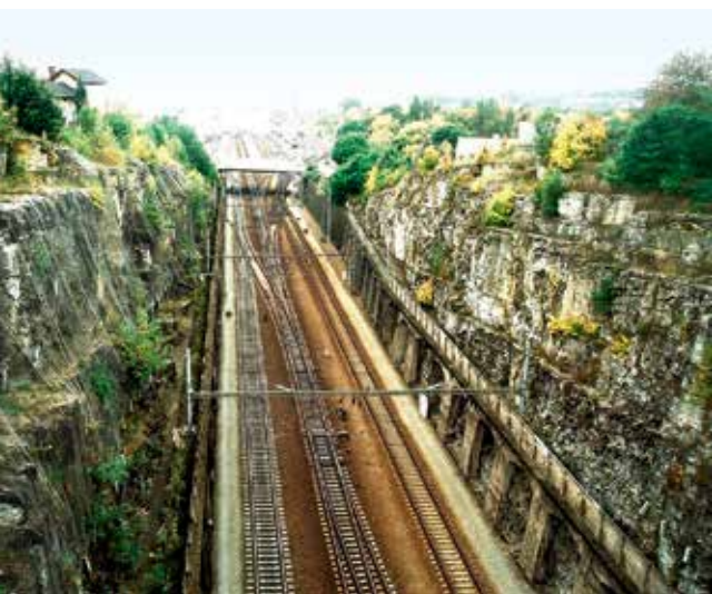
Pohled do prostoru bývalého tunelu v Chocně
