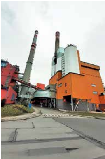
Teplná elektrárna Kunčice
